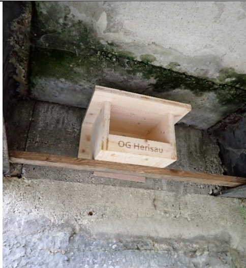
Verschrauben der Kästen auf Latten, die zwischen Stahlträgern eingespannt werden.
