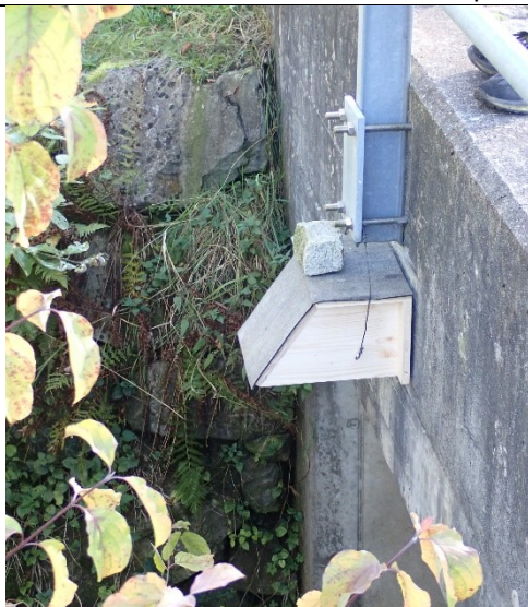
Vorhängen mit Bestigung mittels isoliertem Draht an Brückengeländer Stabilisierung durch Beschweren mit Steinen oder Kleben der Rückwand mit Fliese
