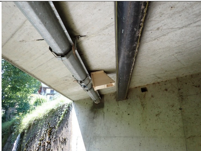
Verschrauben der Kästen auf Latten, die zwischen Stahlträgern eingespannt werden.
