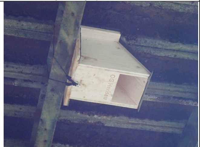
Verschrauben der Kästen auf Latten, die zwischen Stahlträgern eingespannt werden.
