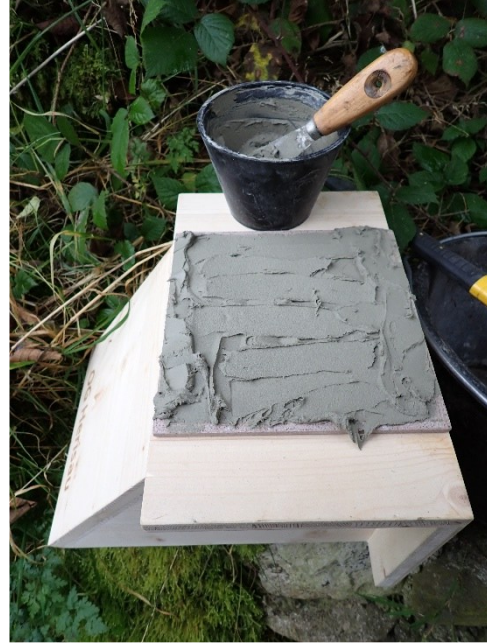
Kauf Flexkleber schnell nach Anleitung angerührt und auf Fliese aufgetragen
