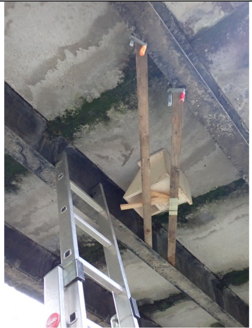
Stippering zum Kleben der Kästen über Querstreben zwischen Eisenträgern
