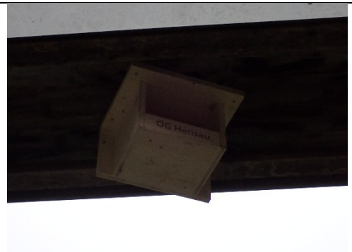
An Holzbrücken anschrauben (oben oder seitlich) vorstehendes Dach respektive Rückwand erleichtert das Anschrauben
