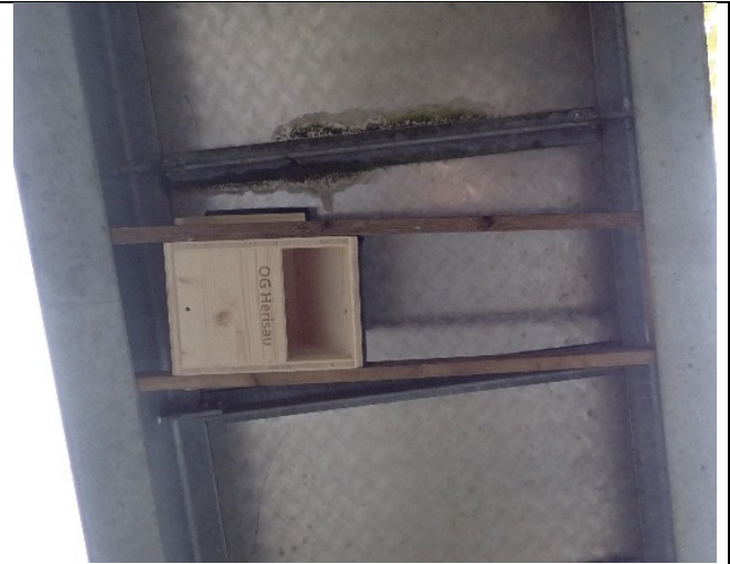
Verschrauben der Kästen auf Latten, die zwischen Stahlträgern eingespannt werden.
