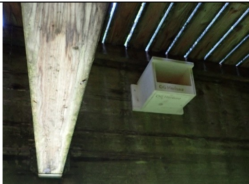
An Holzbrücken anschrauben (oben oder seitlich) vorstehendes Dach respektive Rückwand erleichtert das Anschrauben
